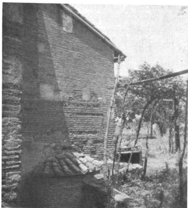
Fig. 164 — S. Giovanni a Porta Latina. Muro terminale dell'avancoro a sinistra e absidiola (1938).
